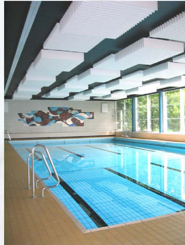
Lamellen-Segel mit unterschiedlichen Höhen
