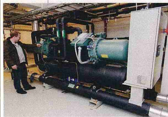
RMEPUMPE: Lars Lunde, enøk-ansvarlig i Asker kommune, ved en mepumpe på 300 kW som er installert for å bruke jordvarme ved Borgen lde. FOTO: KNUST STRØM
