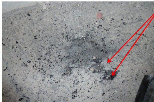
PAK-Reste an Boden und Wänden in den Feuchträumen
