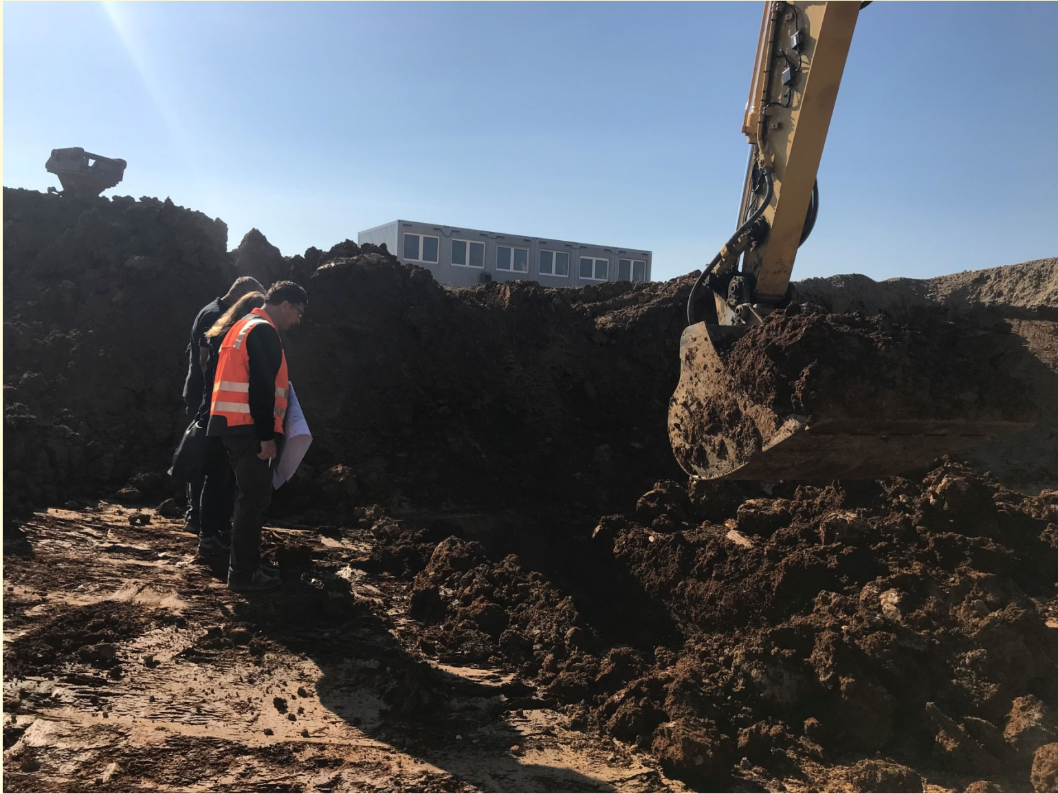
Hochschule Ulm ErsatzNeubau Effizienzhaus Plus
