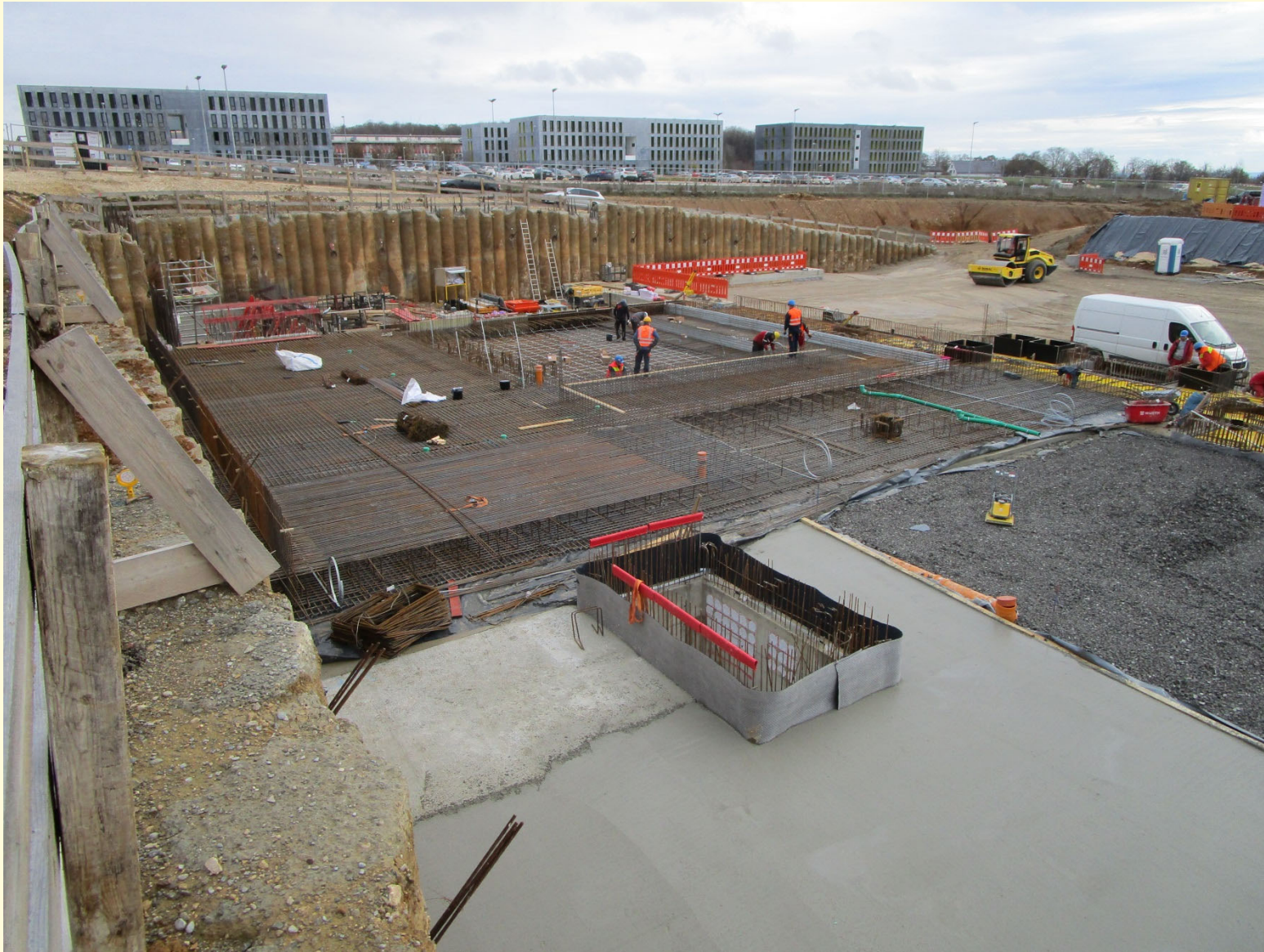
Hochschule Ulm ErsatzNeubau Effizienzhaus Plus
