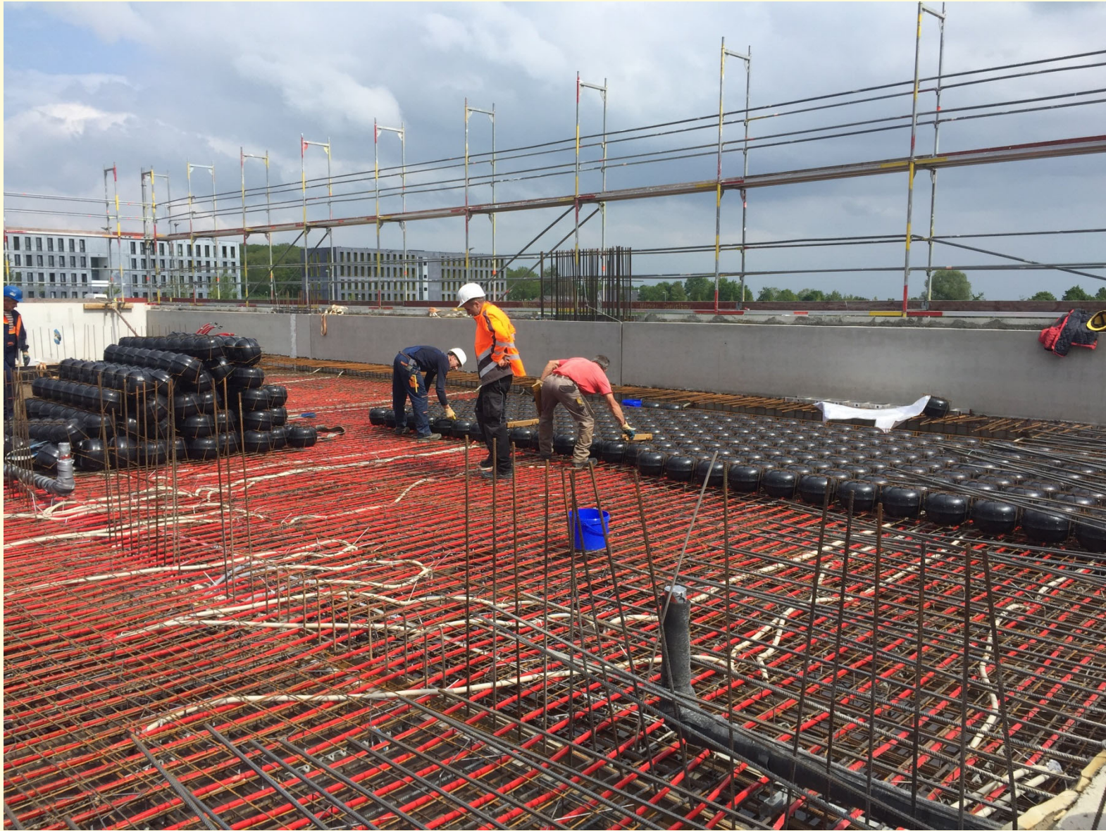
Hochschule Ulm ErsatzNeubau Effizienzhaus Plus
