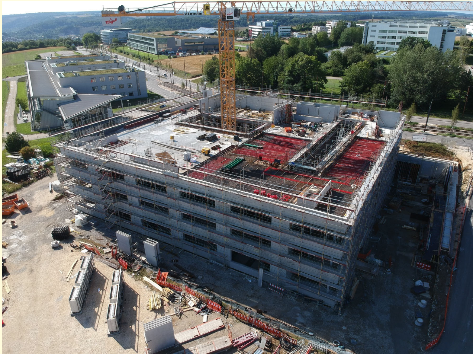
Hochschule Ulm ErsatzNeubau Effizienzhaus Plus
