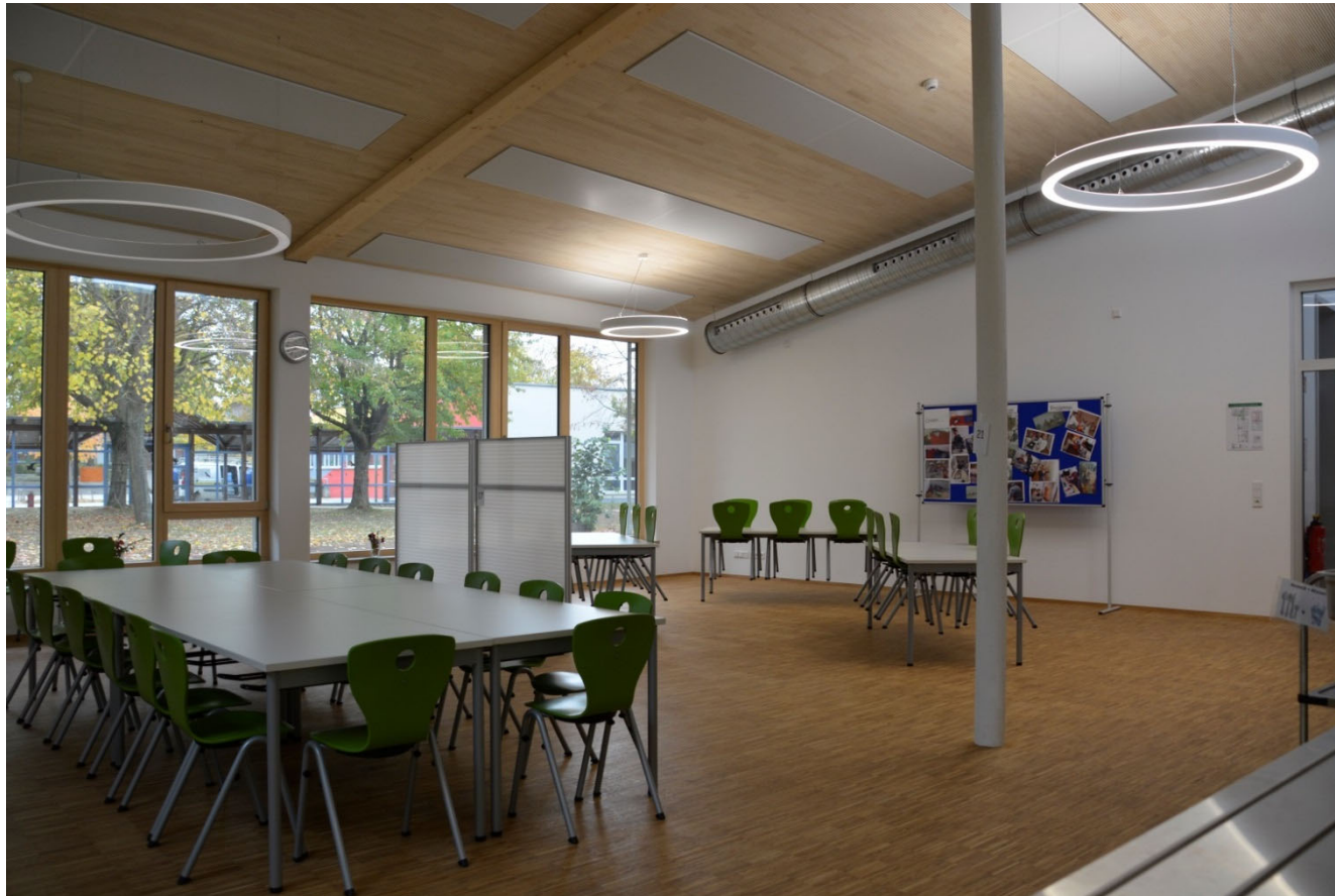
Mehrzweckraum, Holzakustikdecke mit Heiz- und Kühlpaneels
