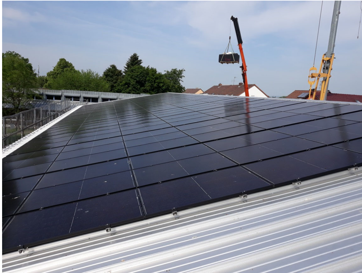
Vollflächig belegtes Solardach 234 m 2 , 54,6 kWp
