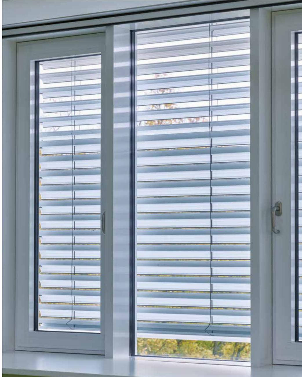
Die Lamellen im oberen Fensterbereich lenken das Tageslicht tief in den Raum, während die Lamellen im unteren Fensterbereich ein Zuviel an Sonneneinstrahlung verhindern. / *The slats in the upper area of the window direct the daylight deeply into the room, while the slats in the lower area of the window prevent too much solar radiation.*
