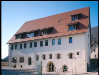
Umbau Stadtbücherei Schloßmühle Bad Urach
