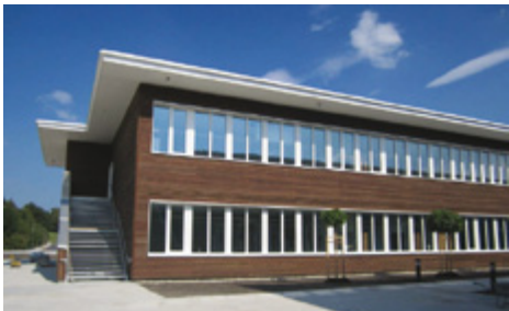
Ganze 61 dezentale Geräte wurden im Neubau des Gymnasiums Buchloe verbaut. Die meisten davon sind Geräte des Typs LTM dezent 800, dem leistungsfähigsten Vertreter der dezent-Familie.
