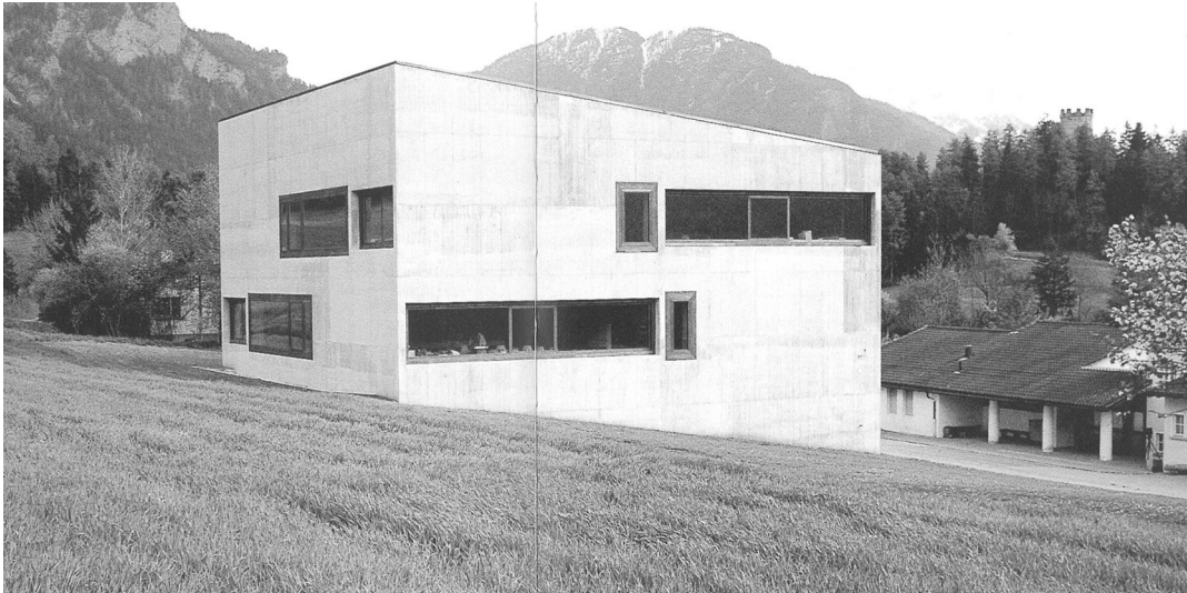
Aussenansicht Oberstufenschulhaus Paspels
