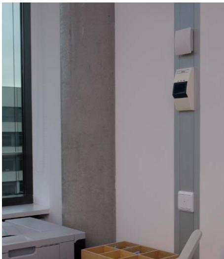
Dozent: Kohlendioxid, Feuchte, Temperatur
