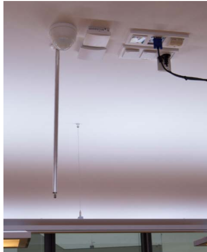
Messinsel: Kohlendioxid, VOC Feuchte, Temperatur, Präsenz
