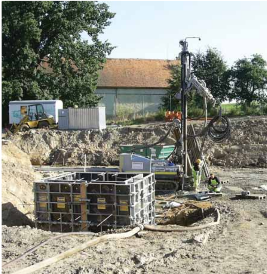
Bohrungen für Erdwärmenutzung (incl. Einbringung Messstellen)
