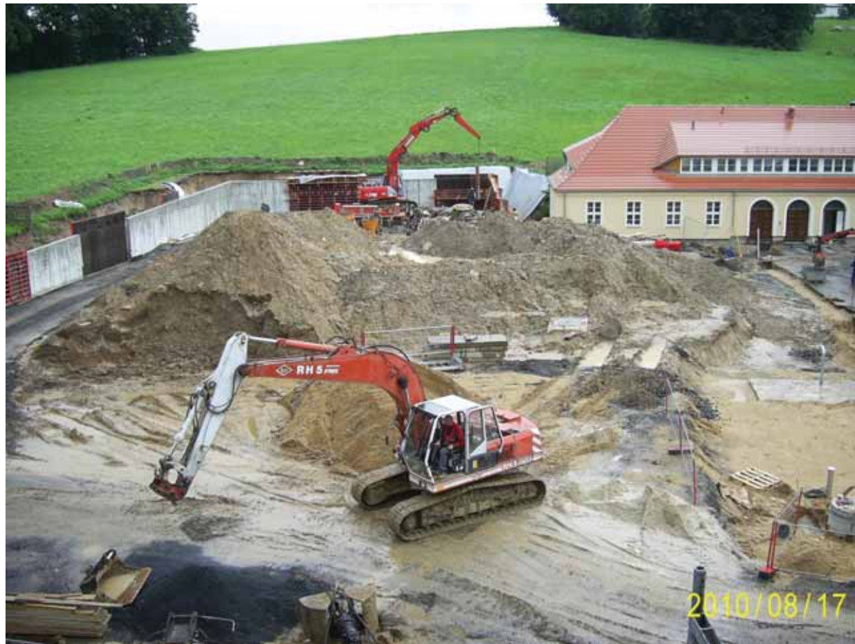
Erdarbeiten auf dem Bohrfeld
