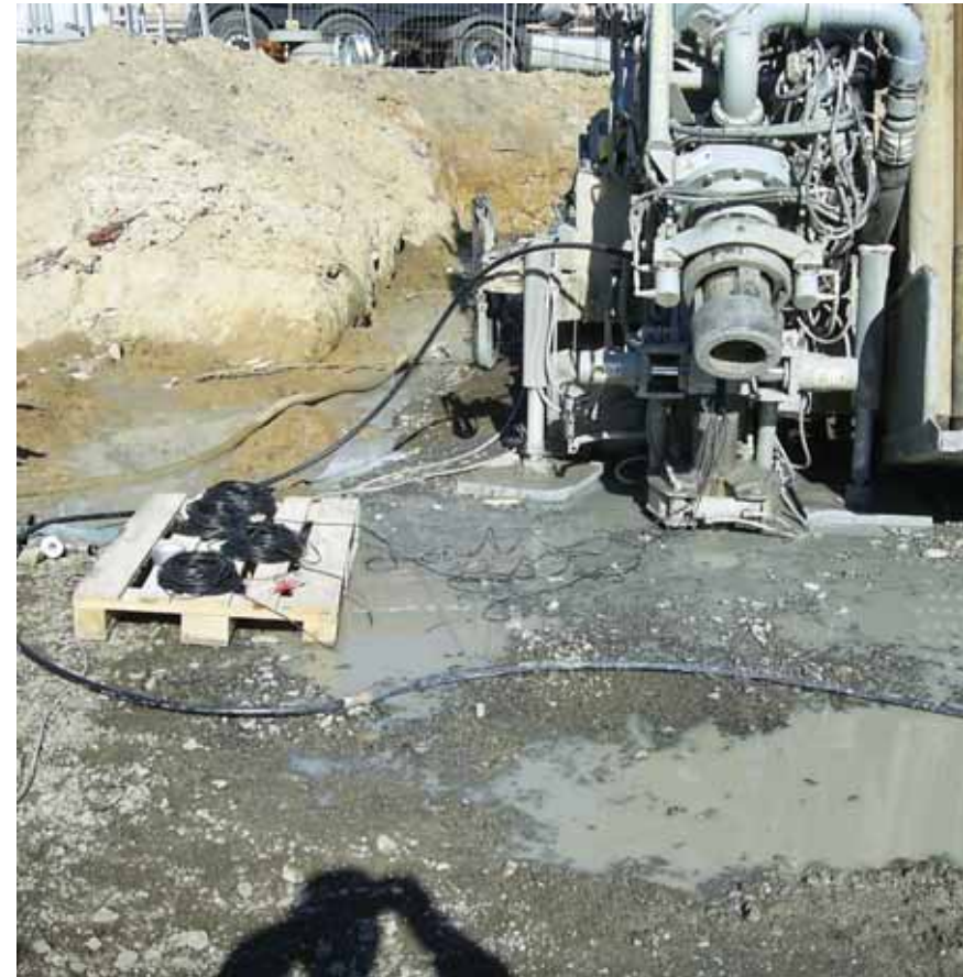
Bohrungen für Erdwärmenutzung (incl. Einbringung Messstellen)
