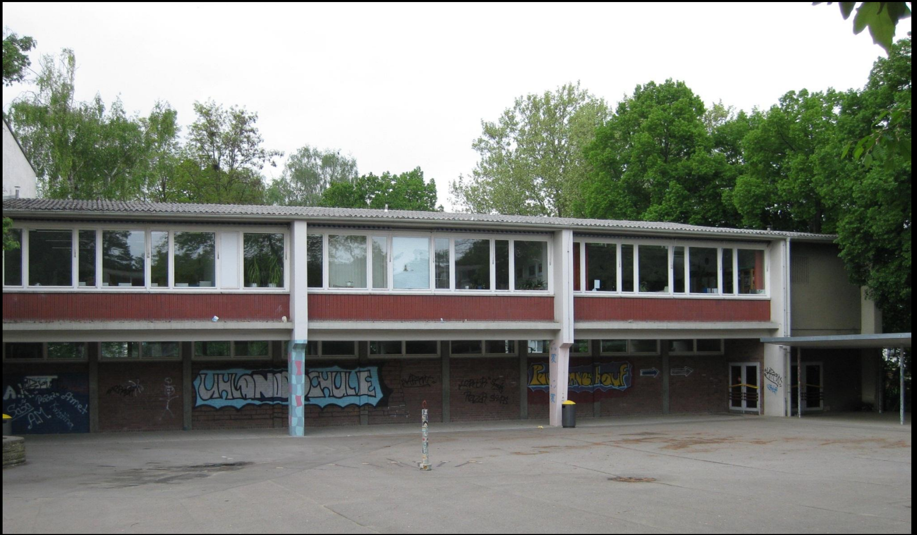
Südseite Hauptgebäude, 2-geschossig
