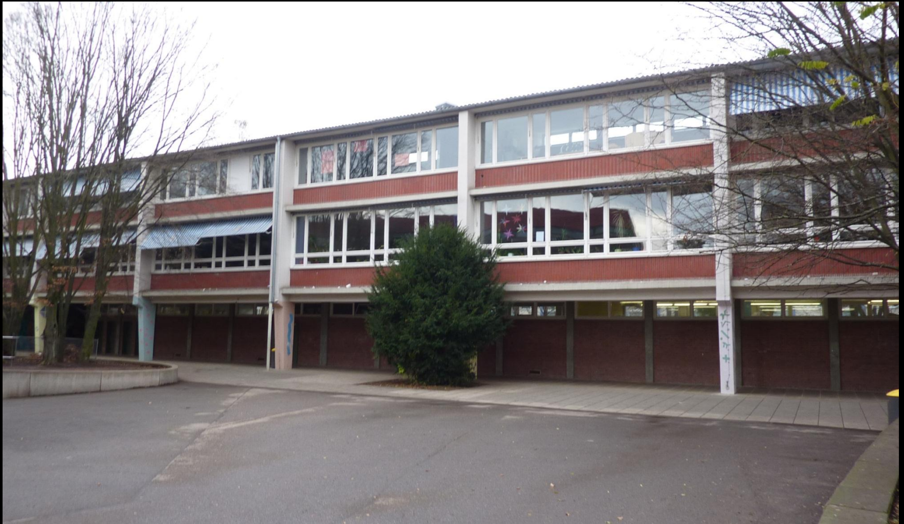
Südseite Hauptgebäude, 3-geschossig
