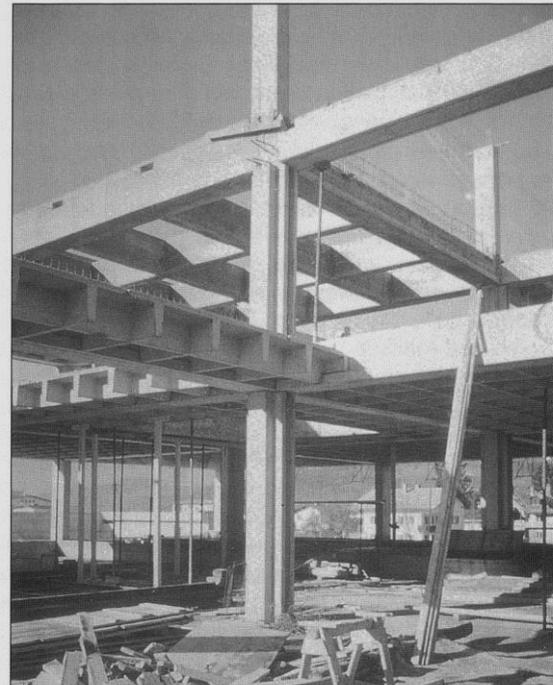
Anschluß Deckenträger an Unterzüge
