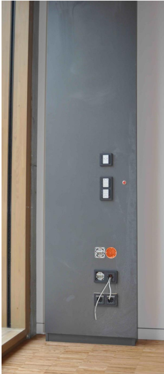
Klassenzimmer/ Elektro- Installations- Paneel neben der Tafel/ Treppenhaus
