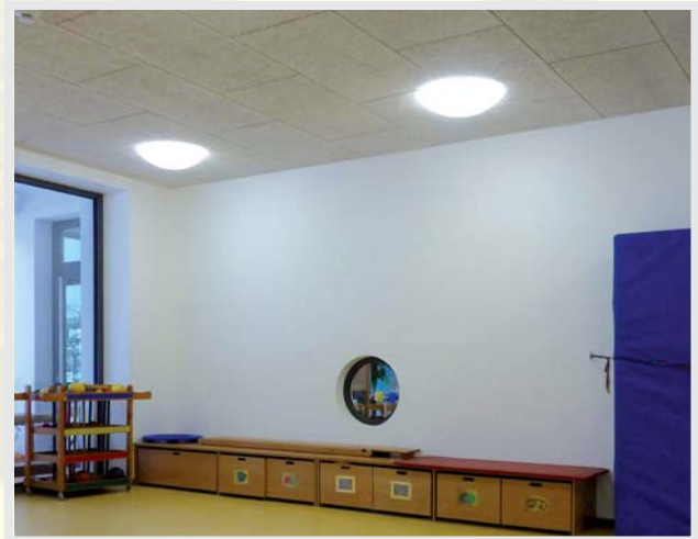
▲ Bild 18 In allen Räumen dienen Decken aus abgehängten Holzwolle- Akustikplatten der Schallabsorption.
