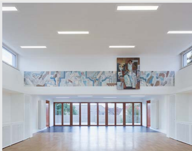
Bild 11 ▲ Bewegungsraum mit Akustikdecke aus gelochten Gipskarton-Bauplatten, seitlich sind die schallabsorbierenden Möbelfronten zu erkennen.
