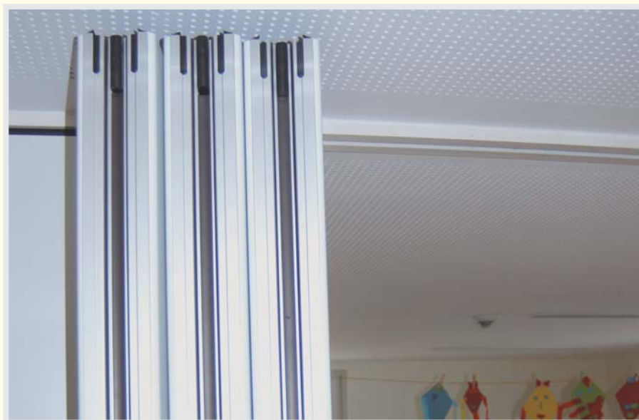
Bild 3 Mobile Wand (offen) zur variablen Raumgestaltung mit akustischer Trennung
