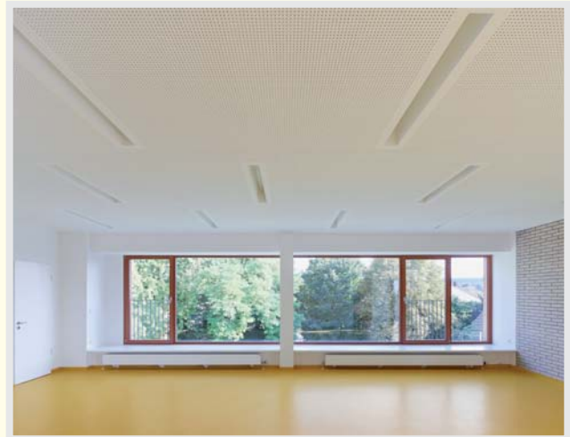
Bild 12 ▲ Akustikdecke mit integrierten schlitzförmigen Vertiefungen für Langfeldleuchten
