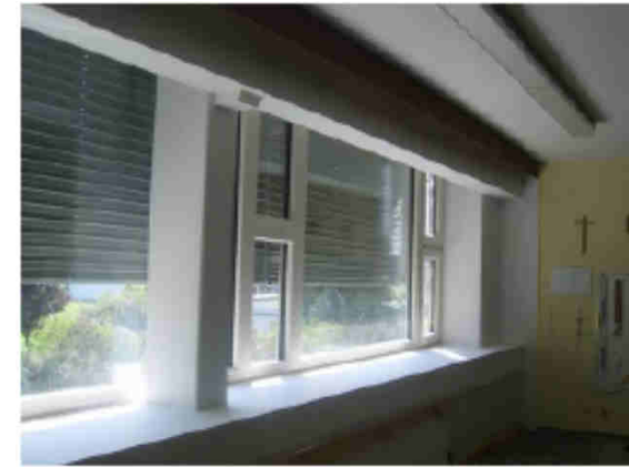
Neue Position der Fenster außerhalb der Stahlbetonträger
