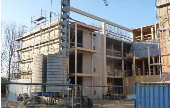
Erweiterungsbau – 1. BA Bauzustand 11.11.11
